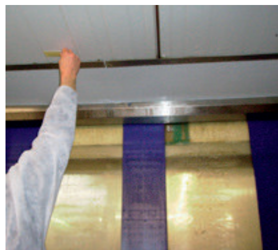
Erfassung der Oberflächenkeimbelastungen - Abklatschtest Decke
